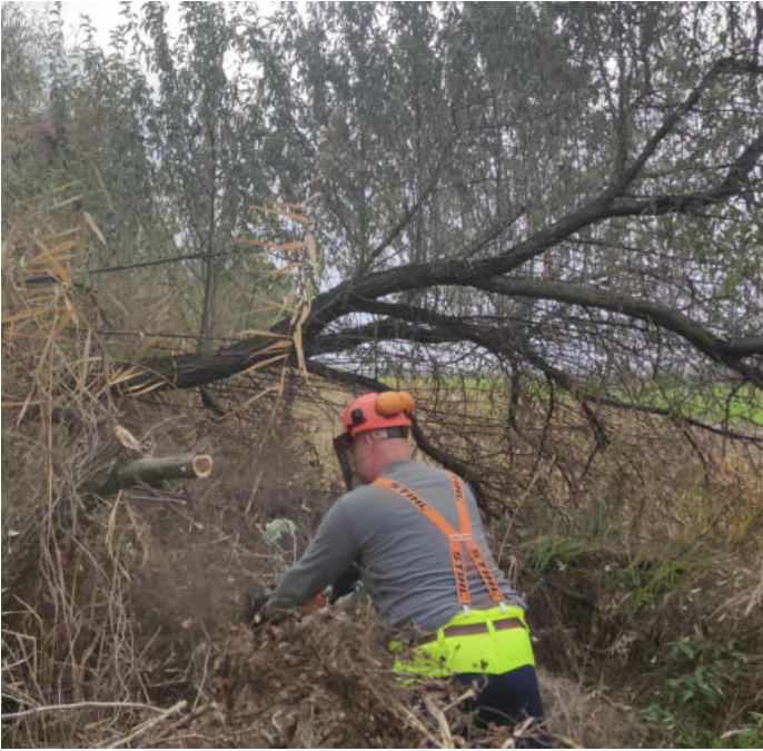
Fakivágás a Szittyó-csatornánál
