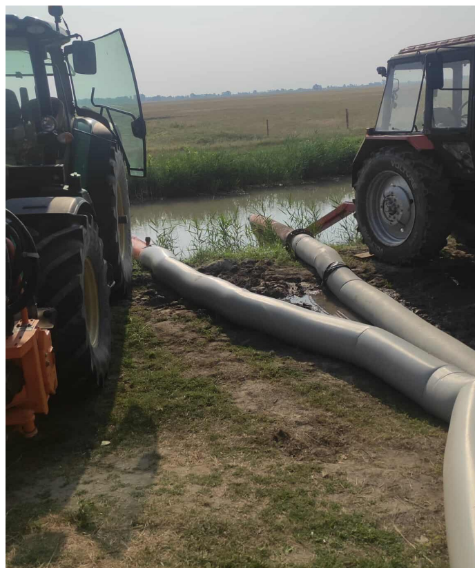
XXXI. csatorna szivattyúzása
