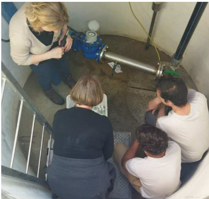
Monitoring kút mintavételezése
