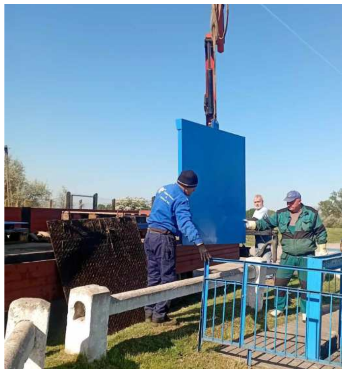
XX. csatorna zsiliptáblájának rekonstrukciója (Dabas)
