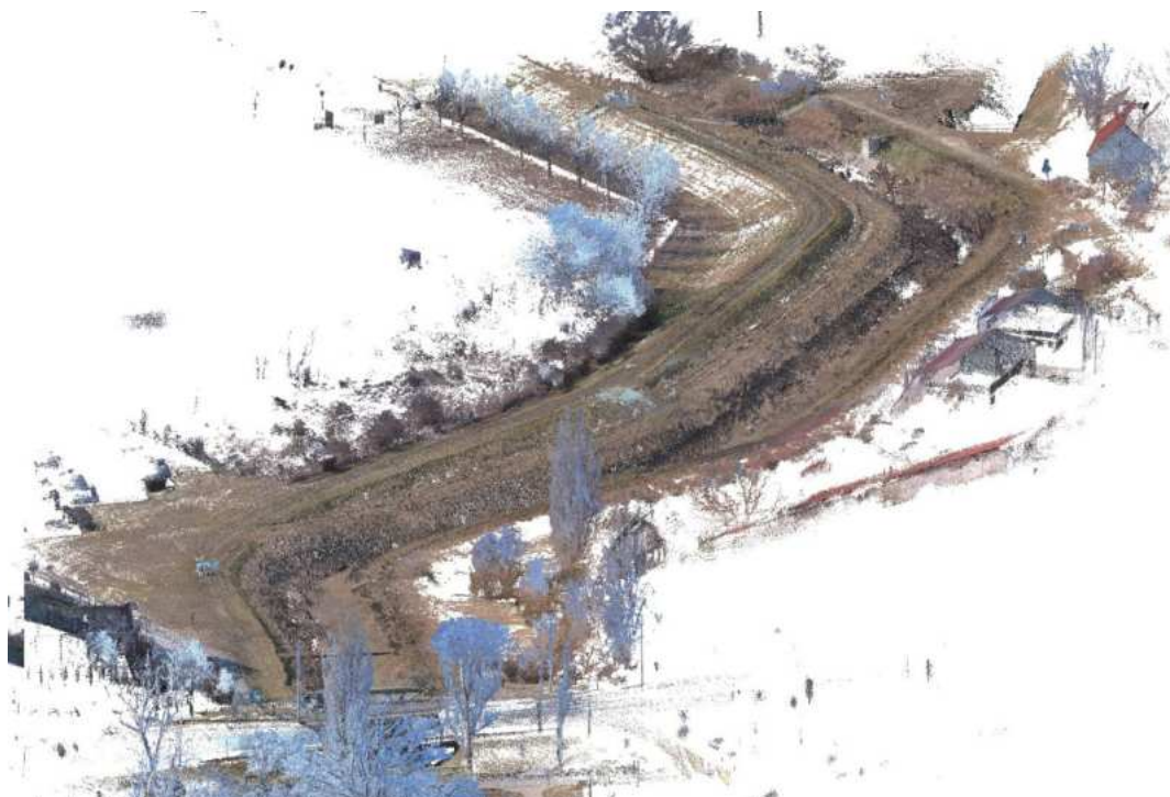
4. kép: A Budakalászi Árvízvédelmi szakasz töltésének és a Dera-patak medrének felmérése, a Lixel Kitty K1 kézi lézerszkennerek segítségével
