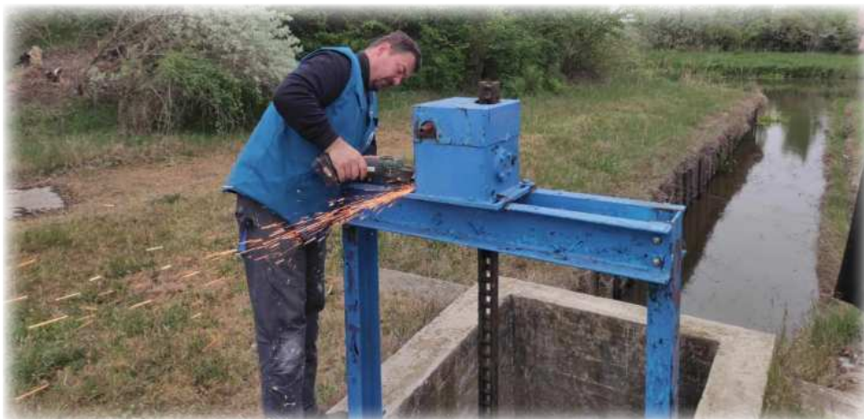
Szittyó-csatorna, műtárgy karbantartás
