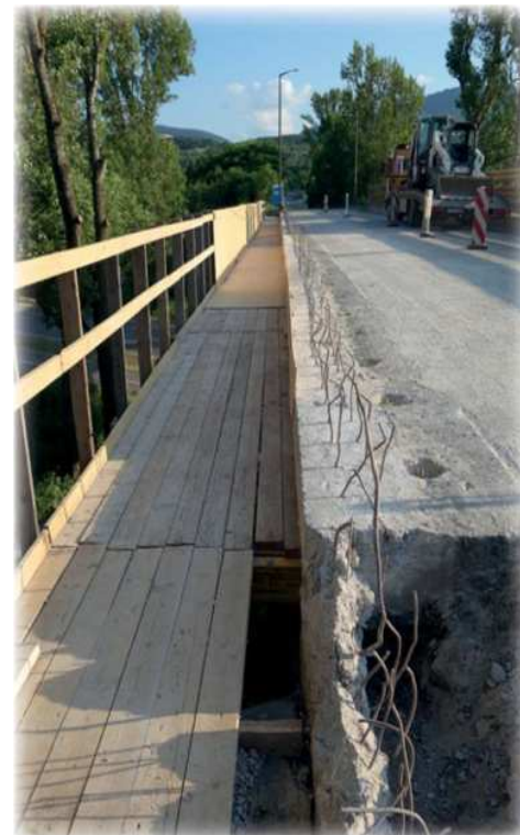
Konzolosan kialakított állványzat, elbontott hídszegély, felmárt burkolat
