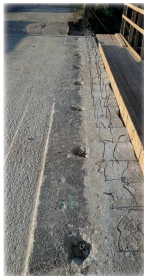
Új hídszegély kivitelezés közben
