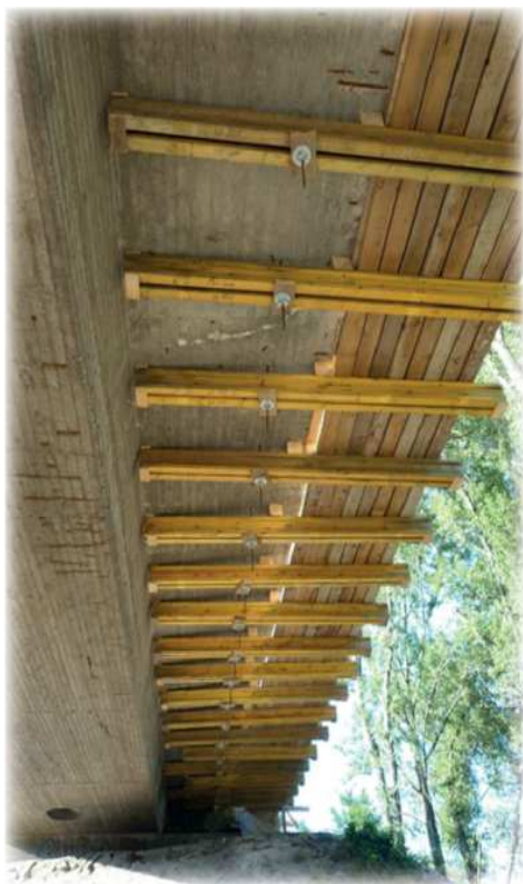
Konzolosan kialakított állványzat
