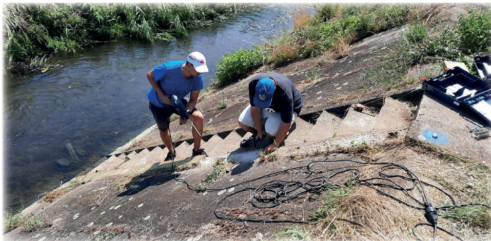
A pásztói vízmérce felújítás közben
